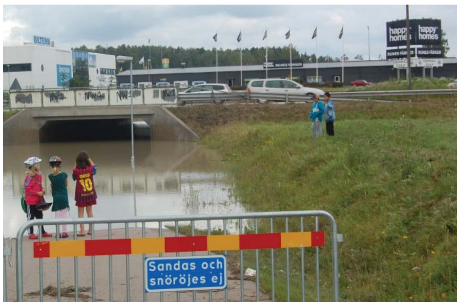
Översvämning vid gångtunnel Erikslund, Västerås. (foto: Mikael Spillman, Svevia)
